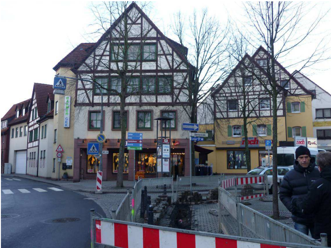
Ecke „Unter den Linden“/Obertorstraße
